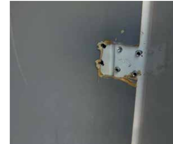
Ausbauspuren im Laderaum
